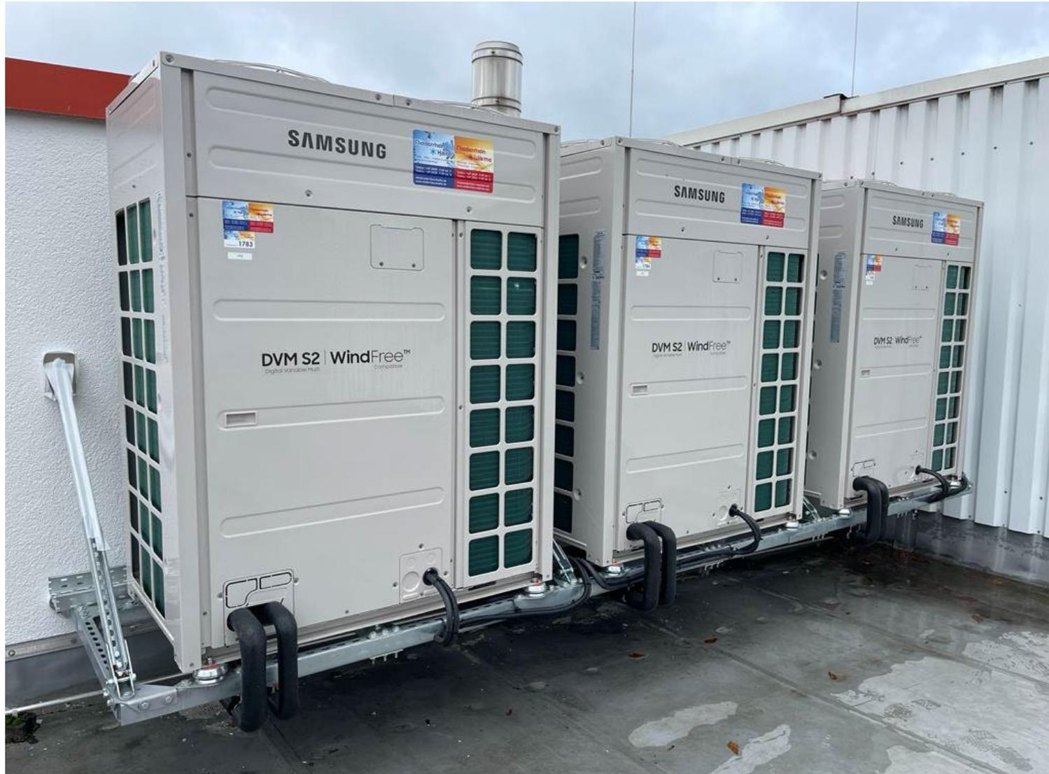
**Die installierte Kühlleistung in diesem Objekt beträgt 152 kW - und die Heizleistung 170 kW**
